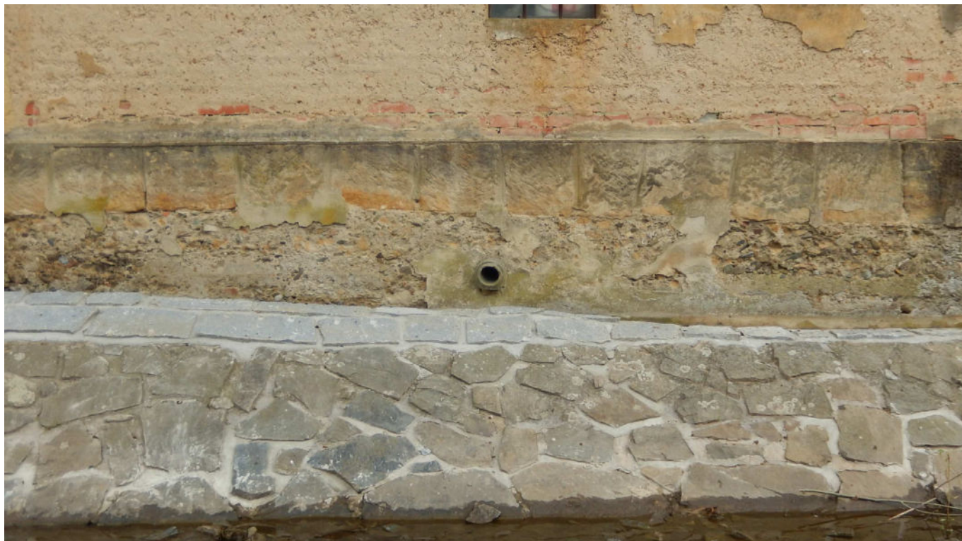
51) VÝUST Č. 9: PB, DN 100, beton
