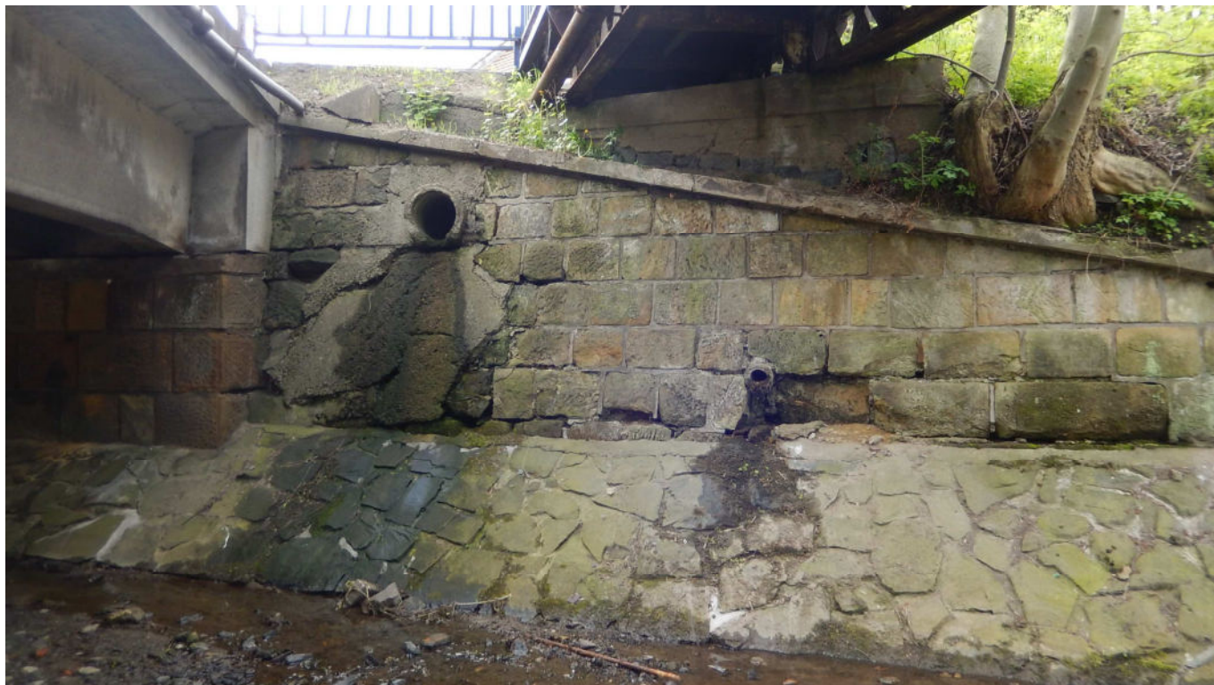
57) VÝUST Č. 15 a 16: LB, DN 100, beton a DN 300 beton
