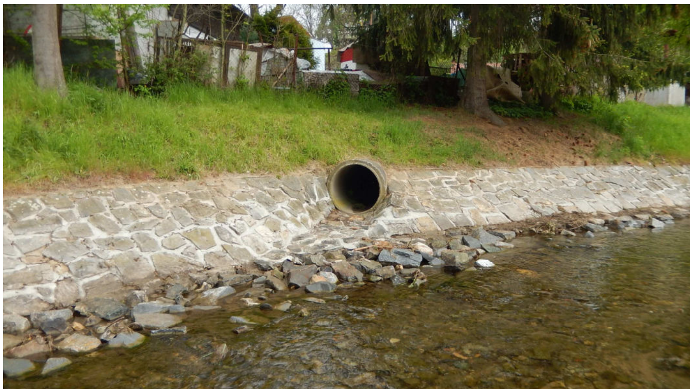
44) VÝUST Č. 2: PB, DN 800, beton
