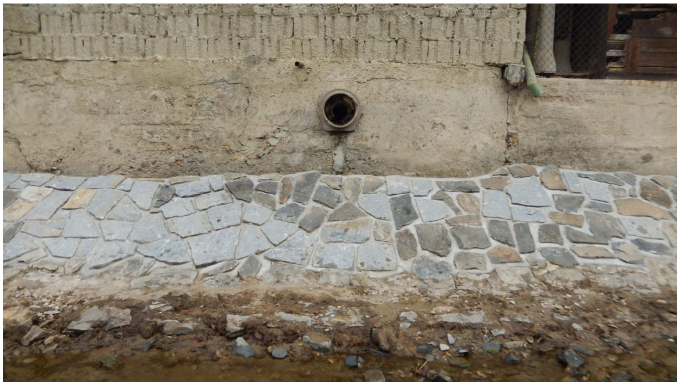
48) VÝUST Č. 6: PB, DN 300, beton
