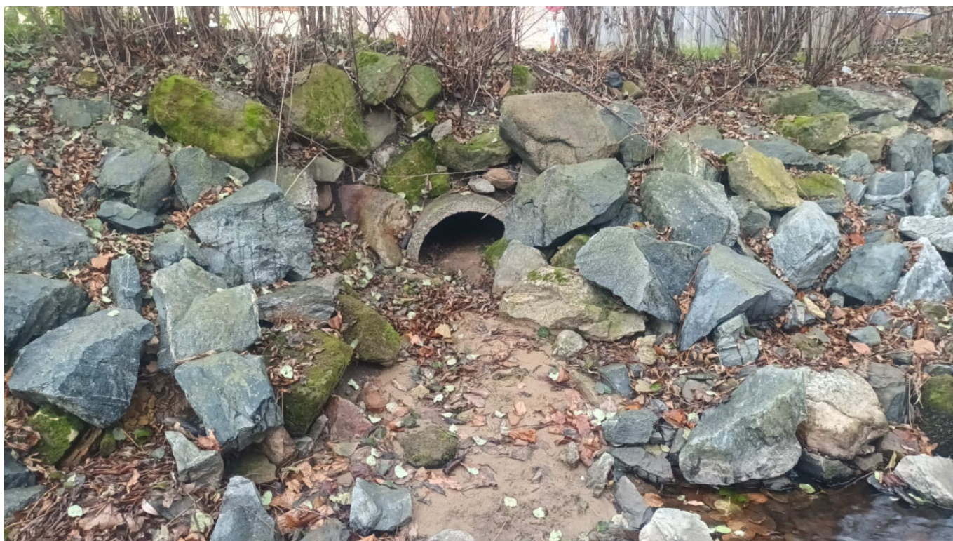
64) VÝUST Č. 26: PB, DN 500, beton
