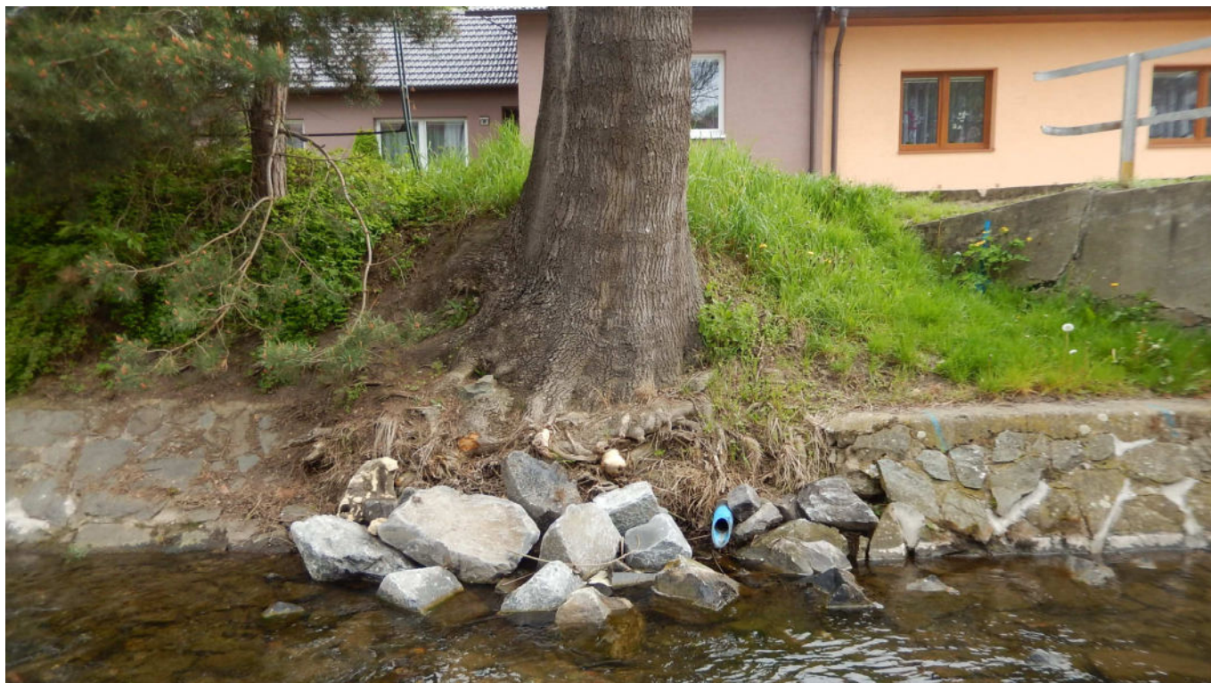
63) VÝUST Č. 23: PB, DN 80, polyetylen (kalník vodovodu pod pařezem)
