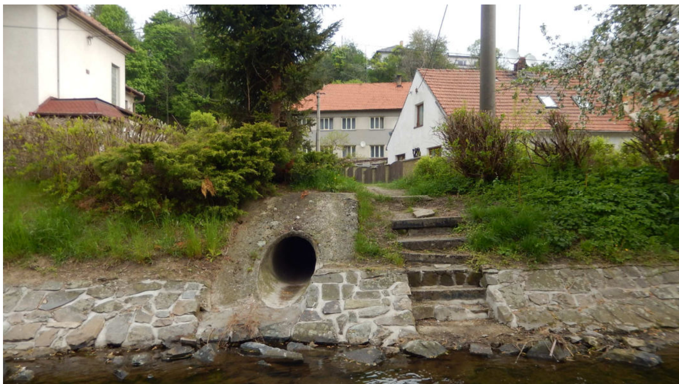
60) VÝUST Č. 19: PB, DN 700, beton
