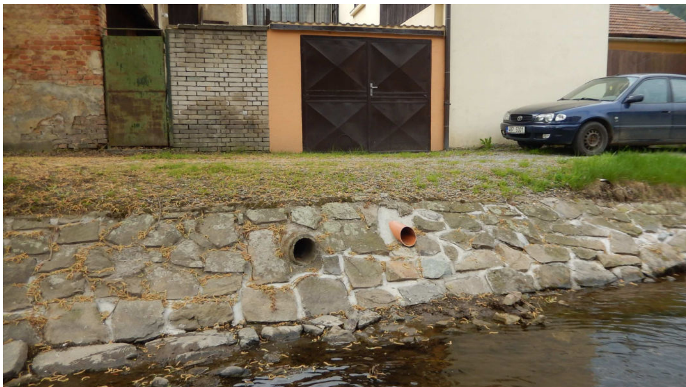
59) VÝUST Č. 18 a20: LB, DN 150, plast a DN 200 beton
